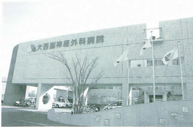
病床数82床のうち、ICUとHCUを4床ずつ設置する大西脳神経外科病院
